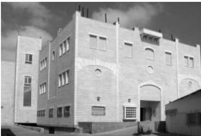
Der Krankenhaus-Neubau des Beit Sahour Medizinischen Zentrums
