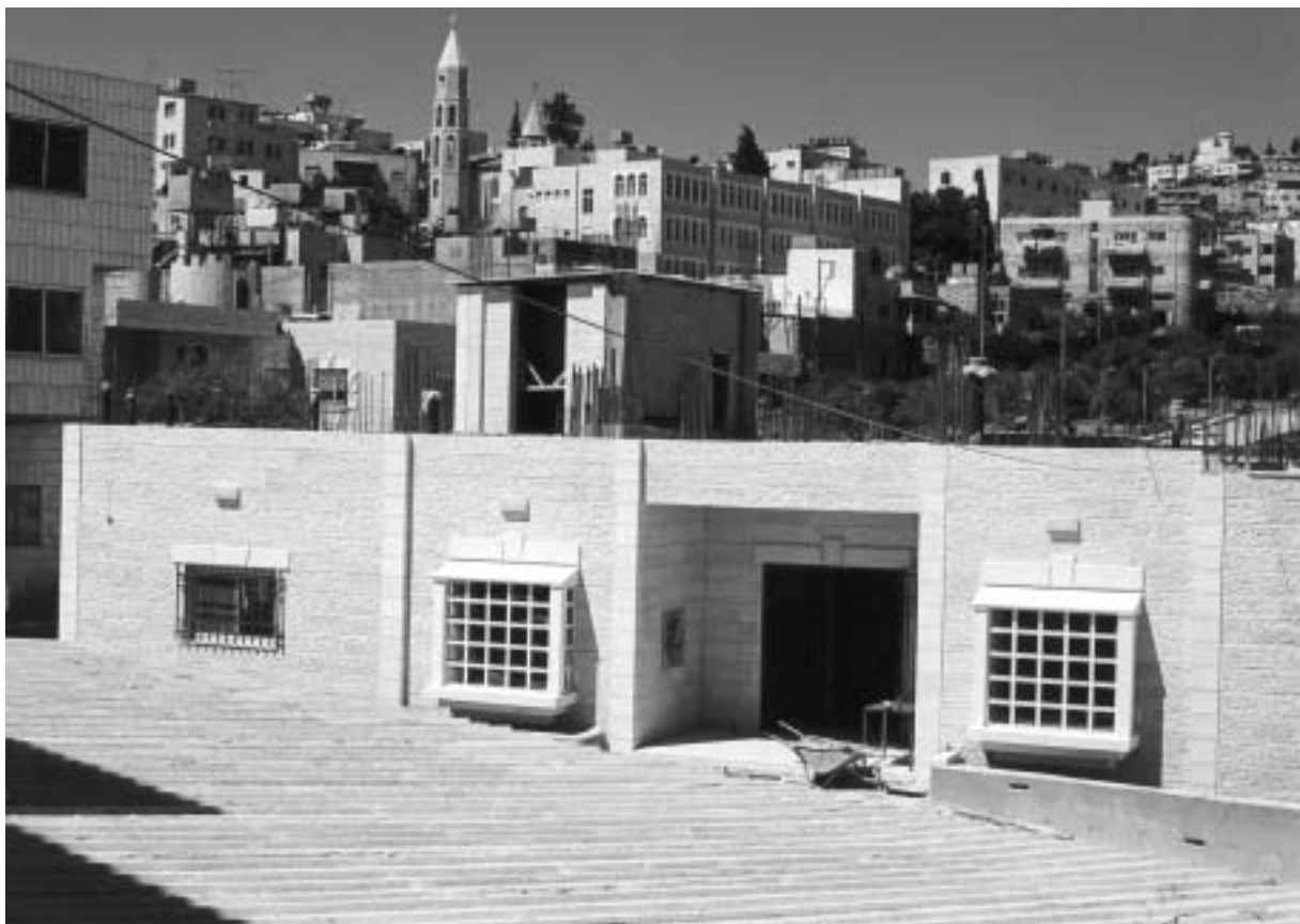
Erdgeschoss des Krankenhauses (Rohbau) im Sommer 2004
