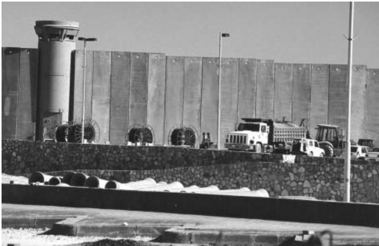
Teilstück der acht Meter hohen israelischen Sperrmauer in Bethlehem
